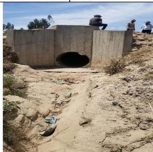
Alcantarilla próxima a la vía
