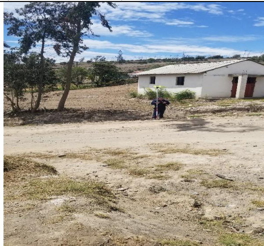
Toma de puntos topográficos con ayuda del prisma
