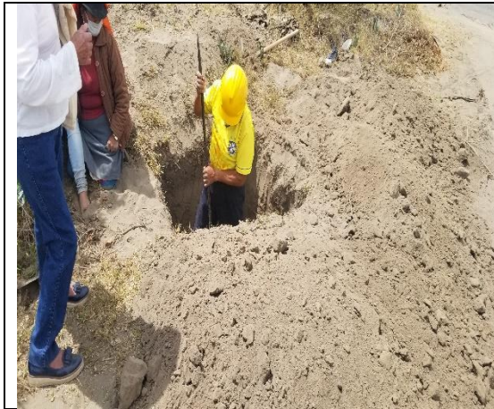
Calicata para toma de muestras
