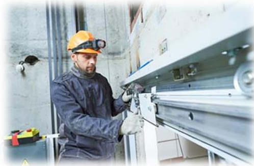
Figura 52. Mantenimiento de las guías del ascensor.
