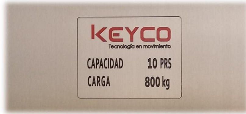
Figura 46. Capacidad y carga del ascensor.
