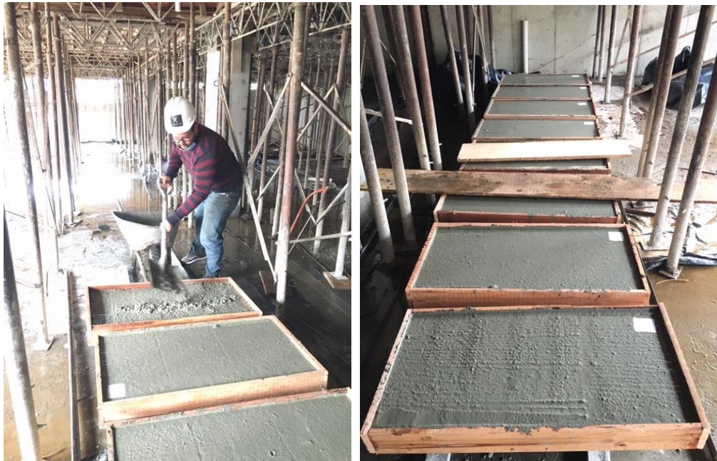
Gráfico 36 encofrado de la losa
