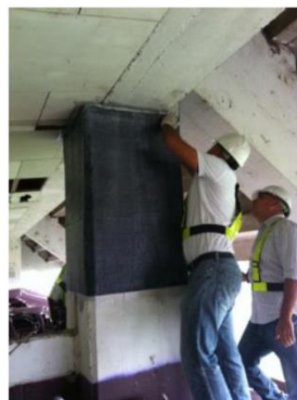
Figura 24: Reforzamiento con FRP
