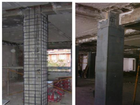
Figura 22: Encamisado de concreto en columna
