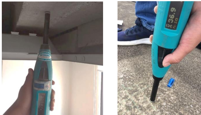
Figura 30: Ensayo con el martillo esclerométrico
