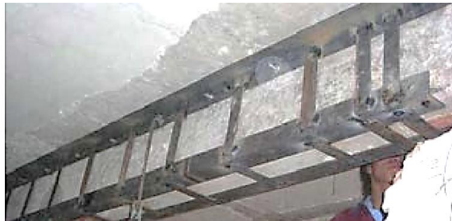
Figura 136: Encamisados de vigas con ángulos y platinas
