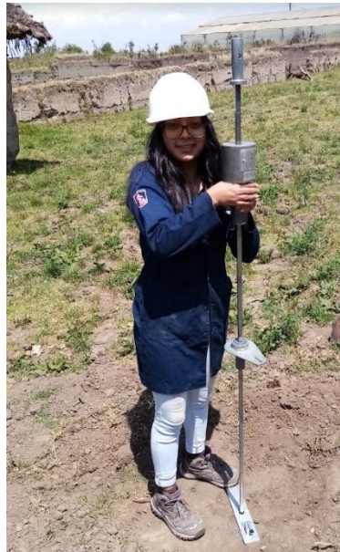
Figura 22. Golpes para la penetración de DCP
