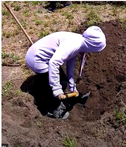
Figura 63. Extracción de la capa vegetal
