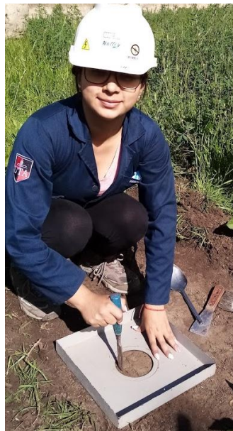
Figura 65. Colocación de la placa metálica
