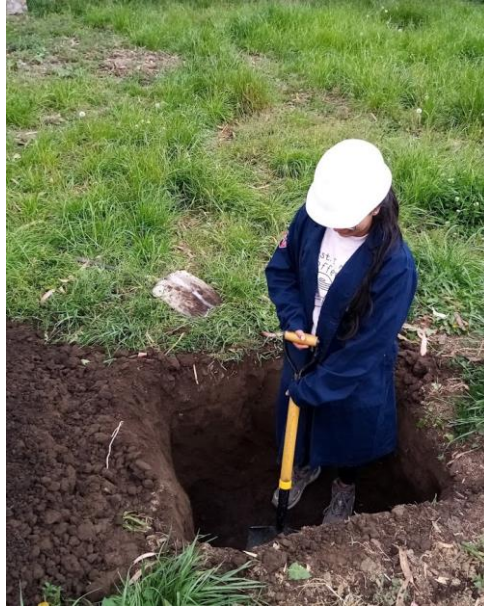
Figura 64. Excavación del pozo 1m de profundidad
