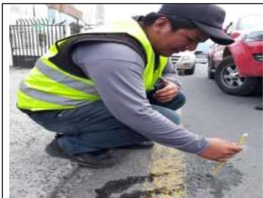
Toma de temperatura capa de rodadura
