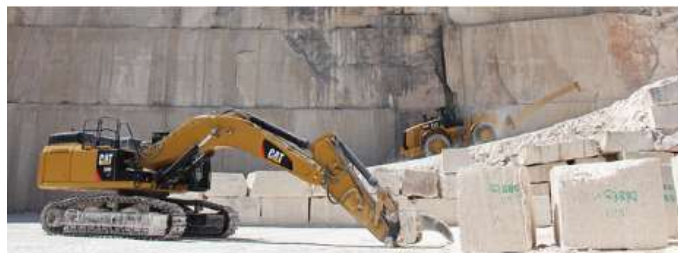
Figura 20. Extracción de la piedra caliza
