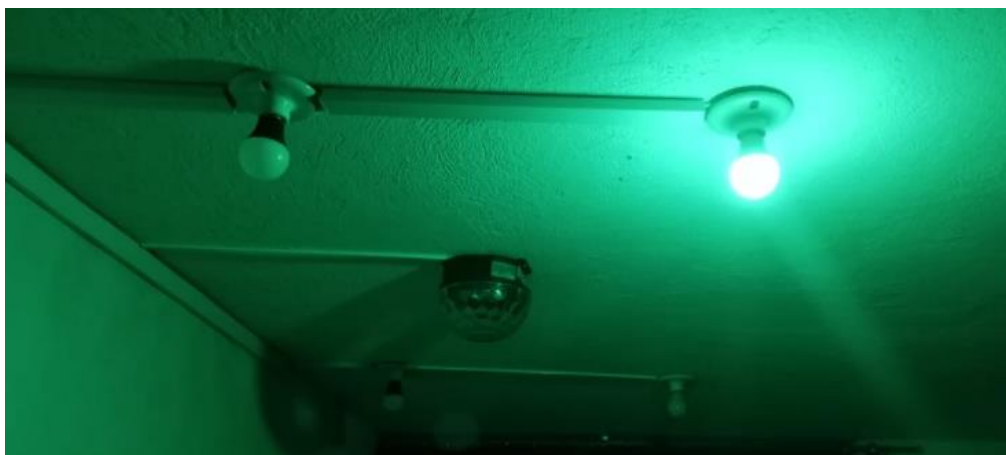
Figura 35: Montaje de los elementos del sistema de iluminación
