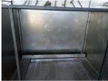
*Figura 42: Forrado de cámara.*
