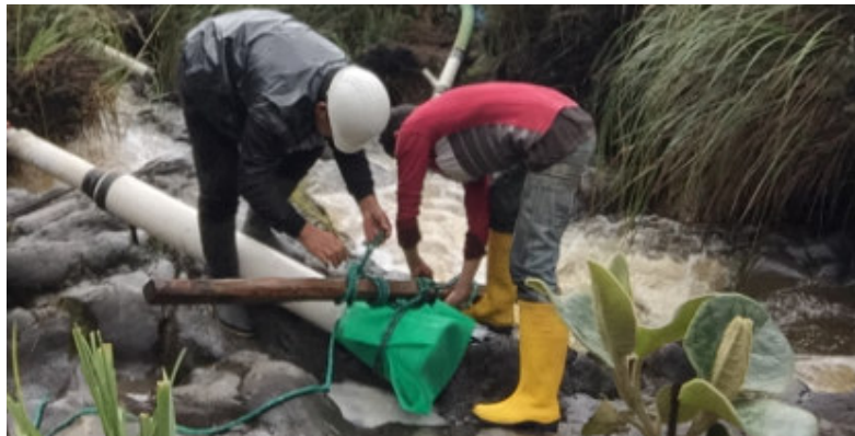
Figura 41: Instalación del arenero
