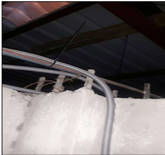
Fotografía N° 2: Armado longitudinal de columna
