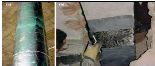
Figura N° 31: Columna con fibra de carbono FRP
