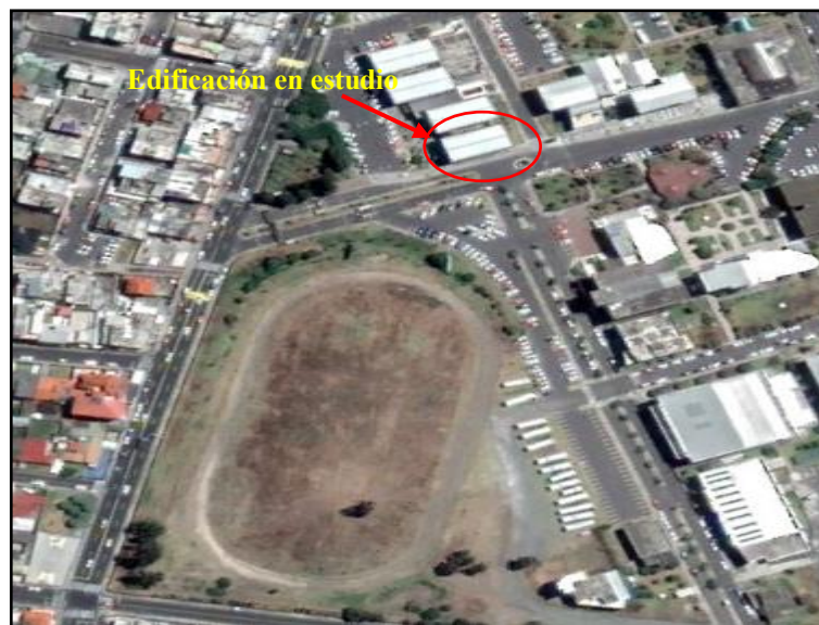
Figura N° 48: Ubicación del edificio en estudio en Google Earth
