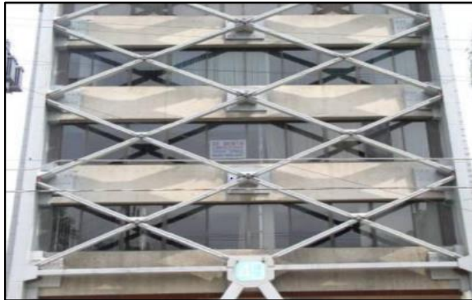
Figura N° 114: Cruces de San Andrés en marcos exteriores
