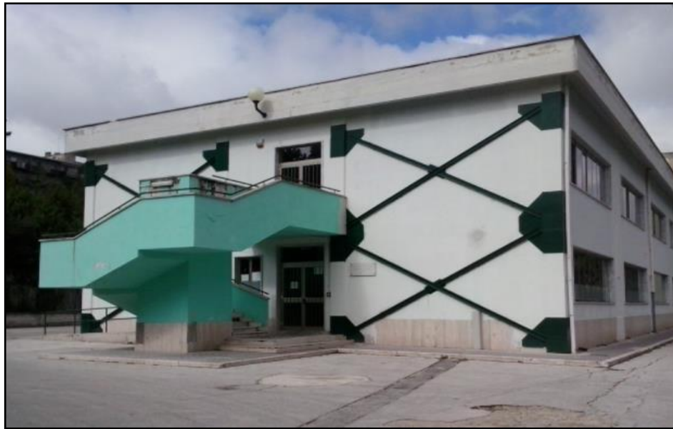
Figura N° 32: Estructura reforzada con contravientos en X
