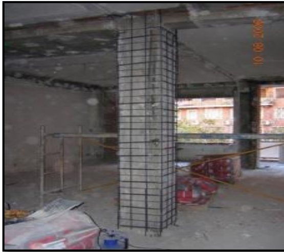
Figura N° 26: Encamisado de hormigón
