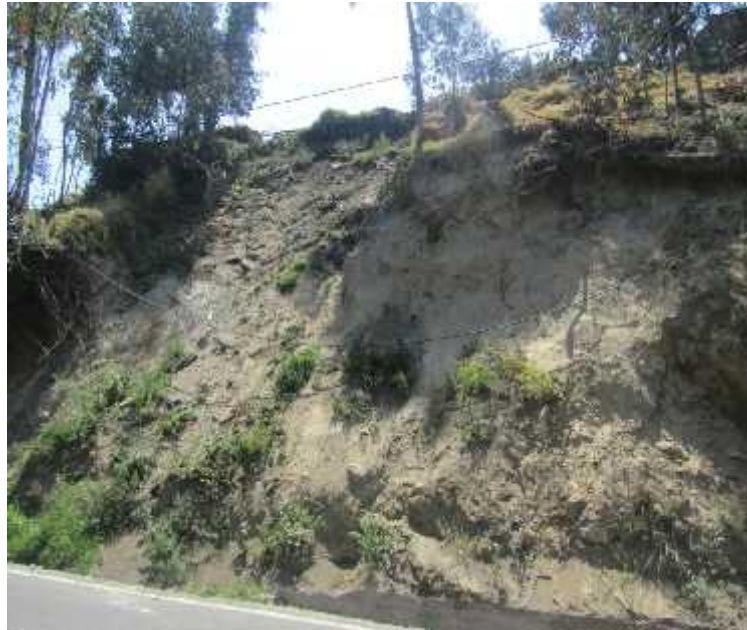
Figura 83: Estado actual del talud
