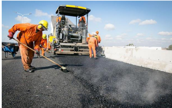
Gráfico 2. Asfalto en obra Fuente: Autocasion
