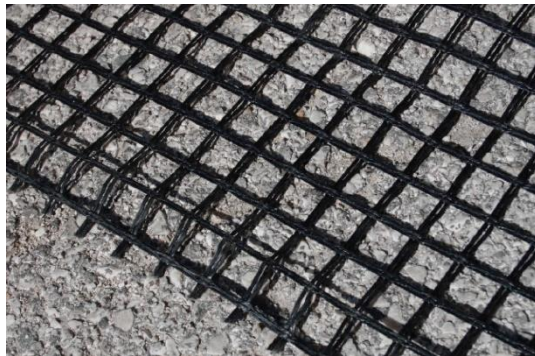
Gráfico 13. Asfalto modificado con fibra de vidrio Fuente: Texdelta (2017)
