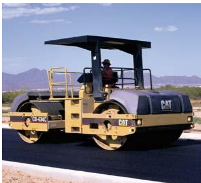
Gráfico 24. Compactado de asfalto en sitio
