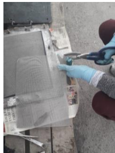
Figura 39: Corte de la malla de acero.
