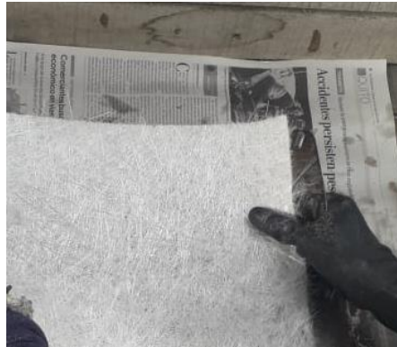
Figura 44: Colocar la fibra de vidrio
