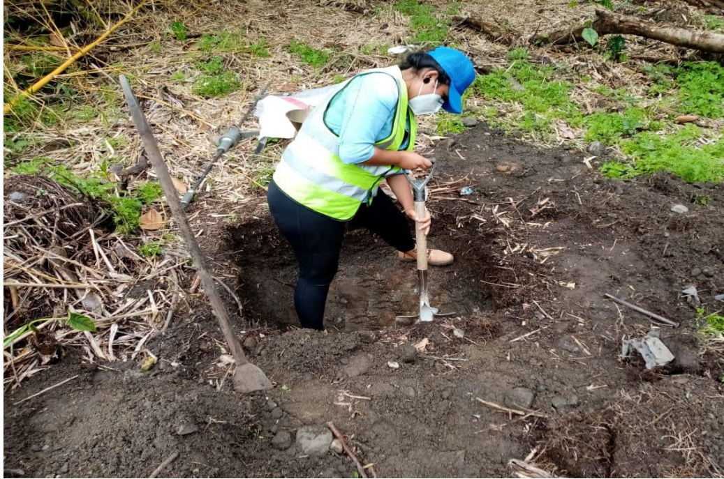
Figura 22. Realización del Pozo a Cielo Abierto
