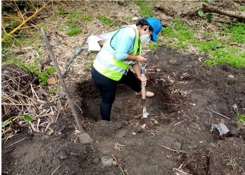
Figura 65. Realización de la calicata
