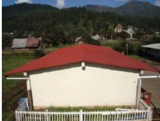
Figura 2. Techos utilizados como áreas de captación de aguas lluvias
