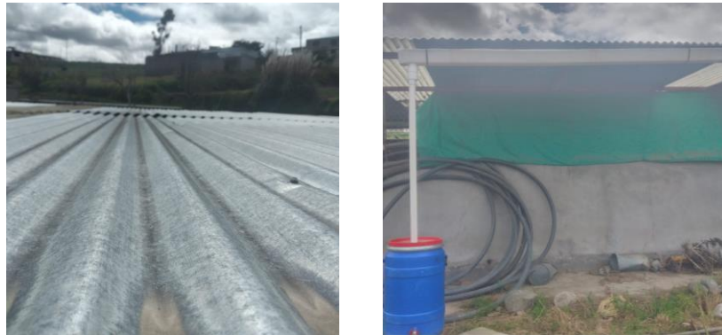
Construcción sistema de aprovechamiento de aguas lluvias
