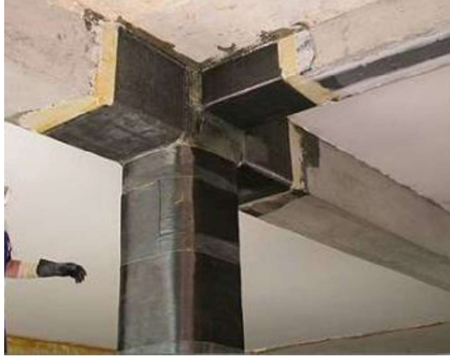
Figura 21: Reforzamiento con fibra de carbono
