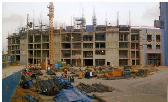
Figura 19: Reforzamiento con Muros de Corte
