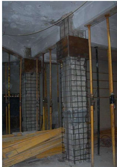
Figura 16: Reforzamiento de columnas mediante recrecido de hormigón armado
