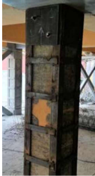
Figura 18: Reforzamiento por medio de encamisado de perfiles metálicos en columnas
