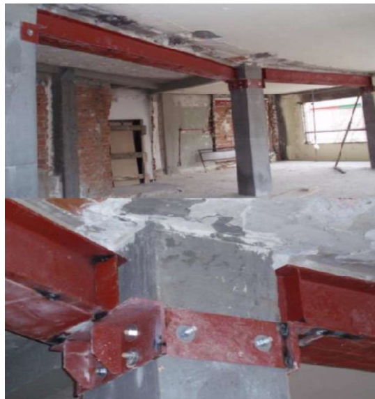
Figura 17: Reforzamiento por medio de encamisado de perfiles metálicos en vigas
