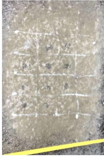
Figura 27: Ensayo con el martillo esclerométrico
