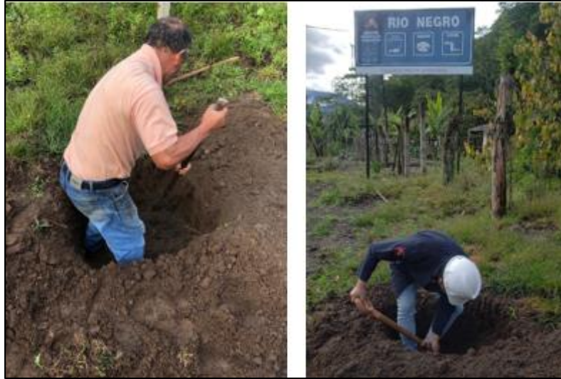
Figura 76: Excavación de calicata. Autor: José Luis López Sánchez.
