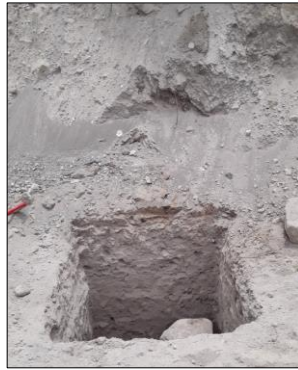
Figura 11: Excavación PCA a 1m de profundidad -Mina Mora
