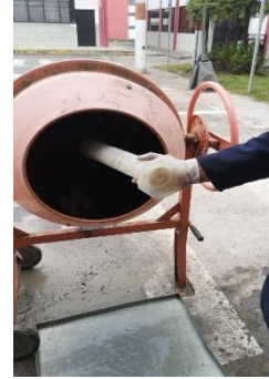
Imagen 2.- Añadir los materiales en la concretora y mezclar
