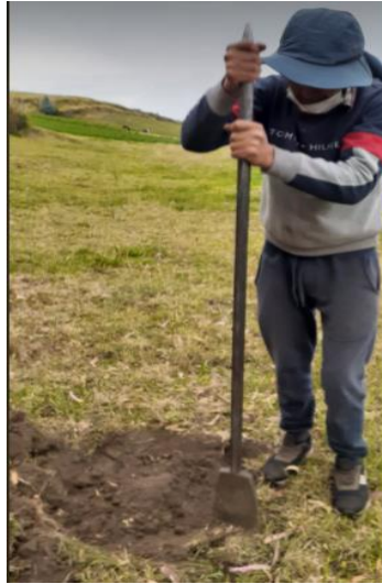
Figura 14. Pozo a cielo abierto
