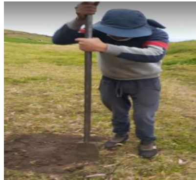
Figura 53. Excavación Pozo a cielo abierto
