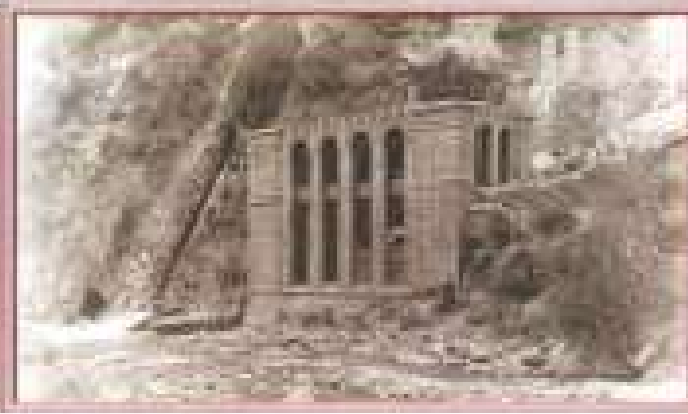
Estación hidroeléctrica industrial Algodonera 1930
