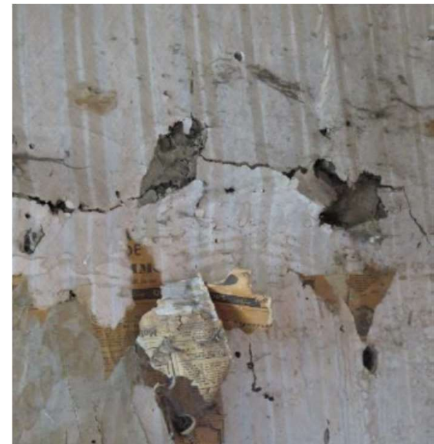
Cielo raso de tabla de madera revestido de papel tapiz y cenefa de moldura de madera
