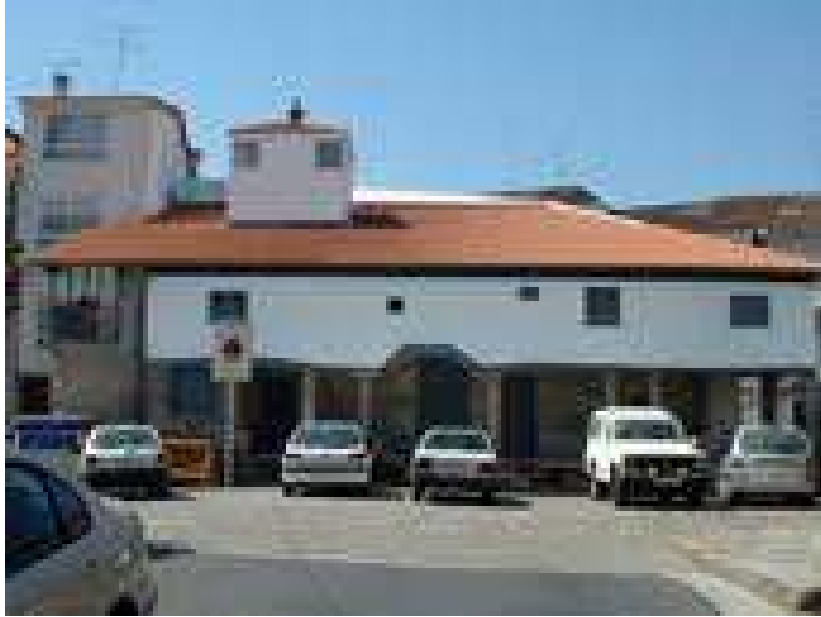
Ilustración 7: Casa De La Cultura De Chantada Fuente: Antes y después (Santoria, 2015); (Castellano, 2014)
