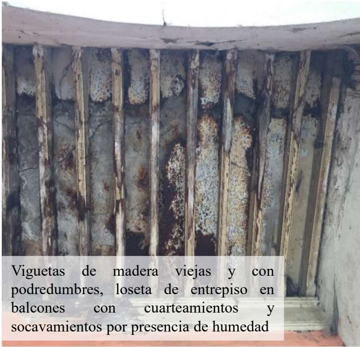
Tramos de losa y estructura de madera destruidas con piezas faltantes, enlucidos viejos y desprendidos de muros portantes de piedra, tabiques de bahareque en ruina.
