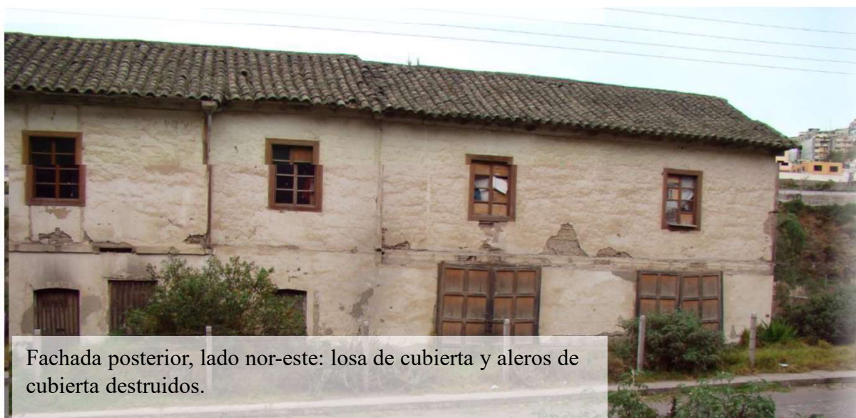
La vivienda se encuentra parcialmente destruida, con un deterioro de más de un 60 % de la cubierta que es de madera y teja y losa en tramo posterior.
