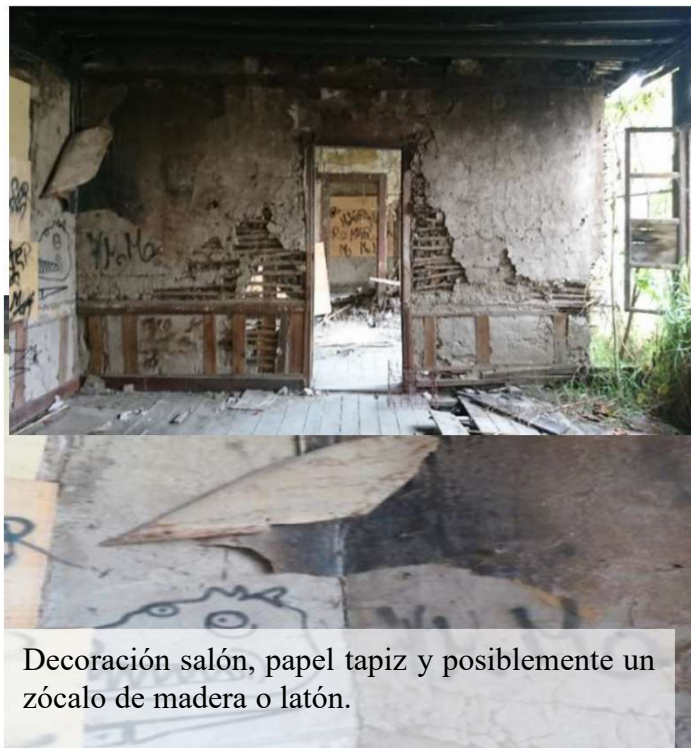
Cielo raso de tabla de madera revestido de papel tapiz y cenefa de moldura de madera, paredes con papel tapiz.
