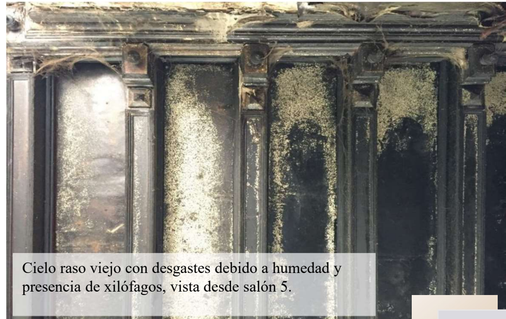
Cielo raso con daños causados por humedad, vista desde salón 15.
