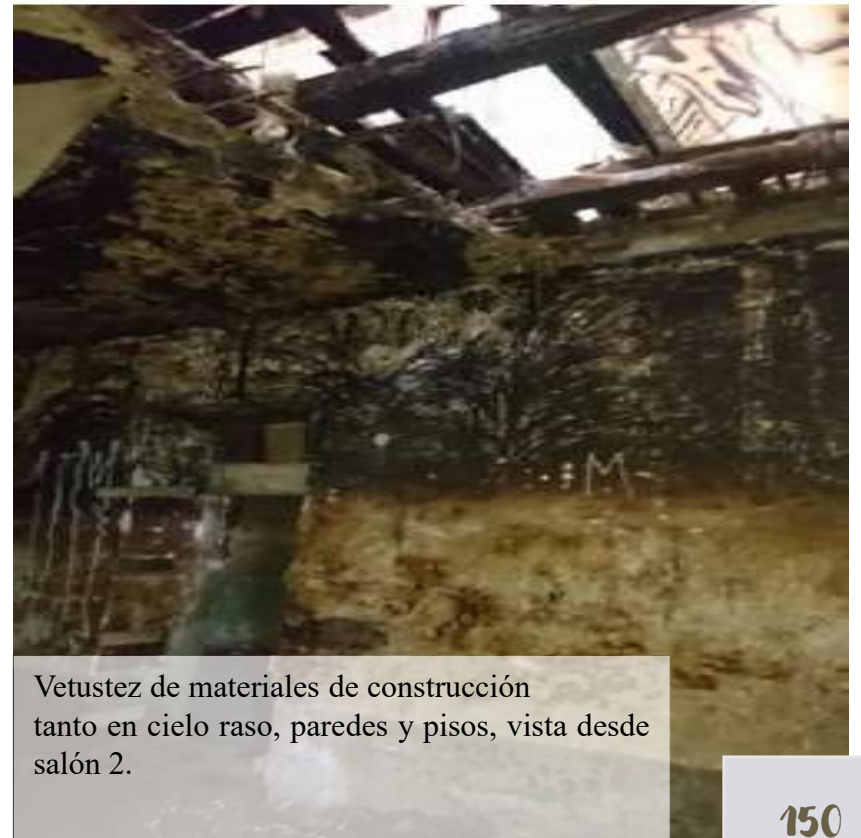
Entrepiso de madera destruido, duelas faltantes. vigas afectadas por fuego provocado.
