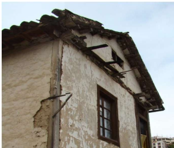
La vivienda se encuentra parcialmente destruida, con un deterioro de más de un 60 % de la cubierta que es de madera y teja y losa en tramo posterior.
