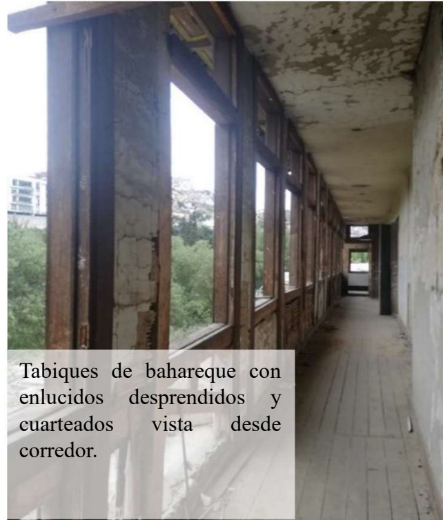
Tabiques de bahareque con enlucidos desprendidos y cuarteados. carpinterías de madera incompletas, cielo raso con daños causados por humedad vista desde corredor.
