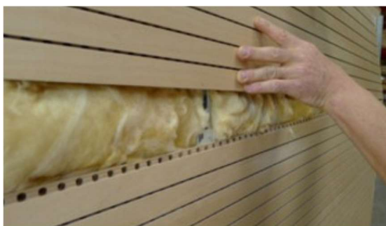
Ilustración 32: Unión de mdF panel FUENTE: (MACISA, 2017)
