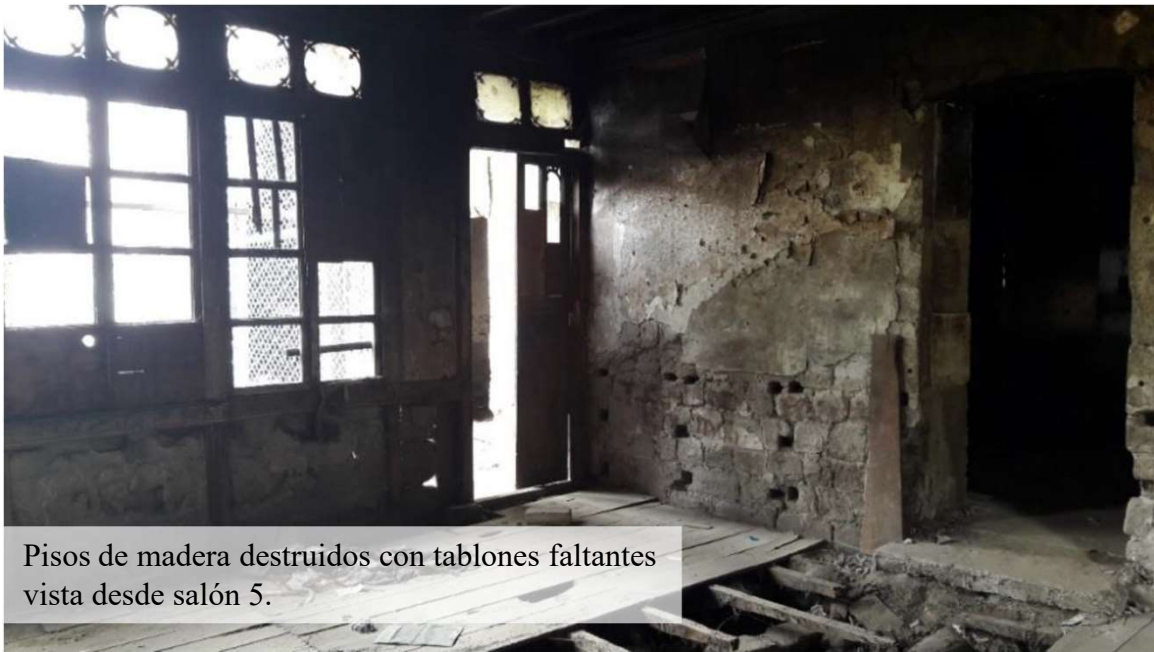
Entrepiso de madera destruido, duelas faltantes. vigas afectadas por fuego provocado.
