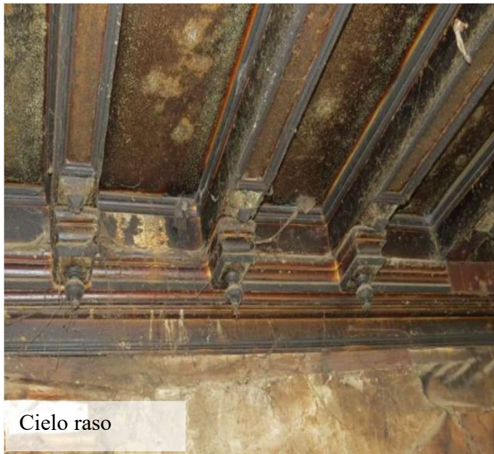
Cielo raso de tabla de madera revestido de papel tapiz y cenefa de moldura de madera
