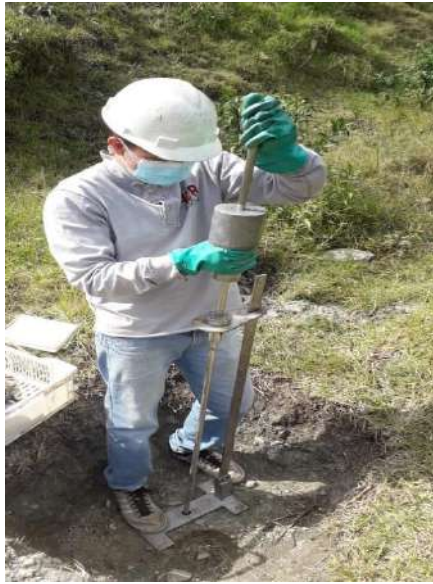
Figura 11. Ensayo de DCP en campo de la vía Lligua-Osohuayco
