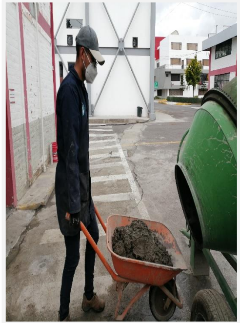
Fotografía 34. Vertido de la mezcla a la carretilla para posterior elaboración de vigas.
