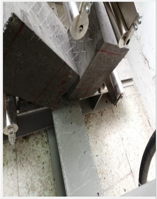
Fotografía 90. Rotura de la viga de hormigón translúcido
