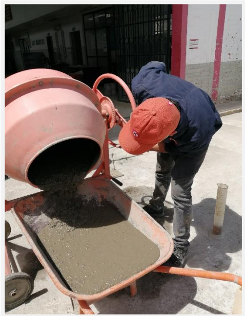
Fotografía 68. Elaboración de la mezcla para cubos de hormigón translúcido
