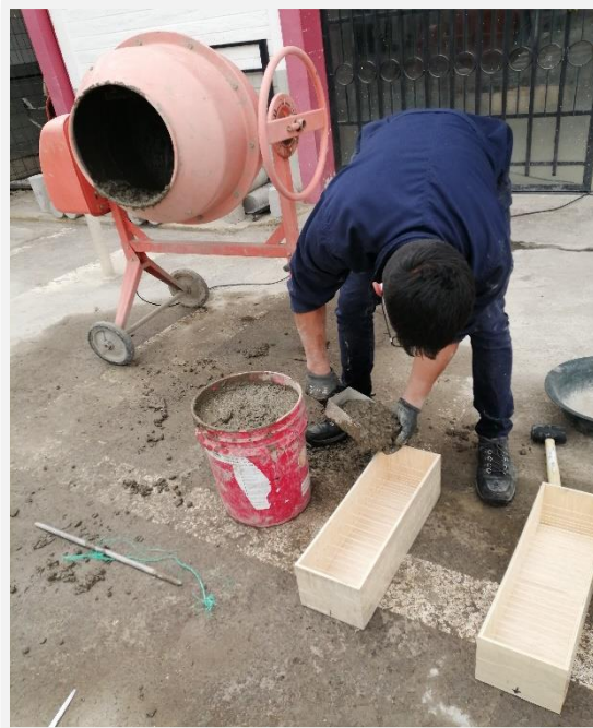
Fotografía 75. Elaboración de las vigas de hormigón translúcido
