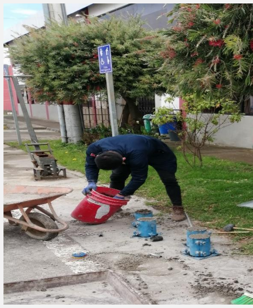
Fotografía 29. Elaboración de cilindros
