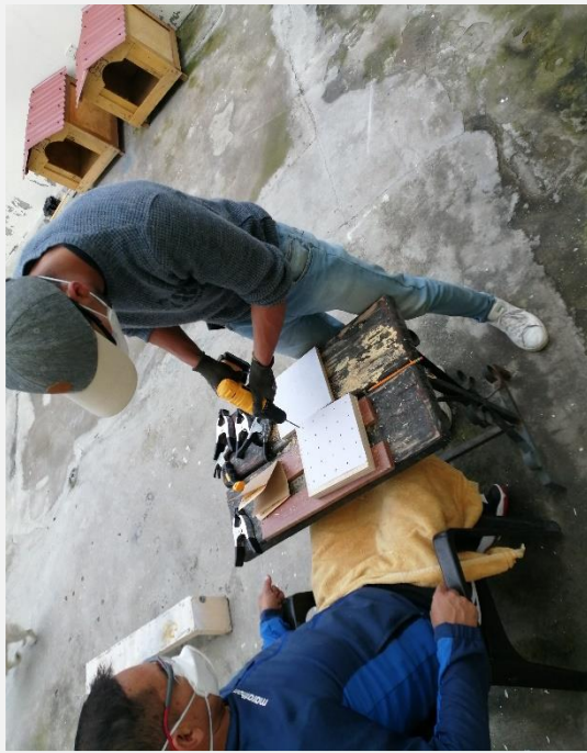
Fotografía 61. Elaboración de huecos para moldes de hormigón translúcido
