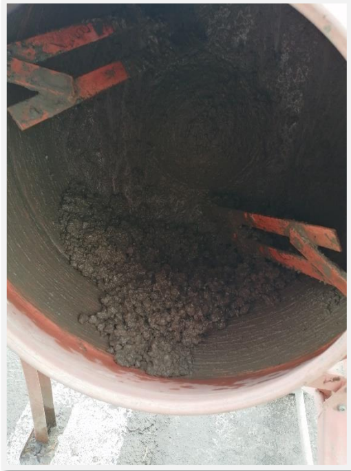
Fotografía 26. Mezcla de los materiales en la concretera
