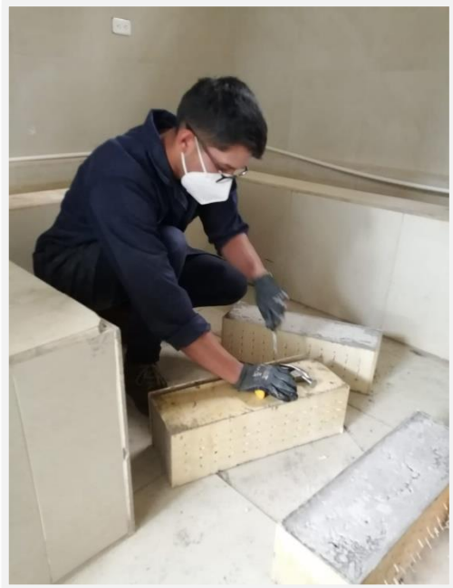
Fotografía 76. Desencofrado de las vigas de hormigón translúcido
