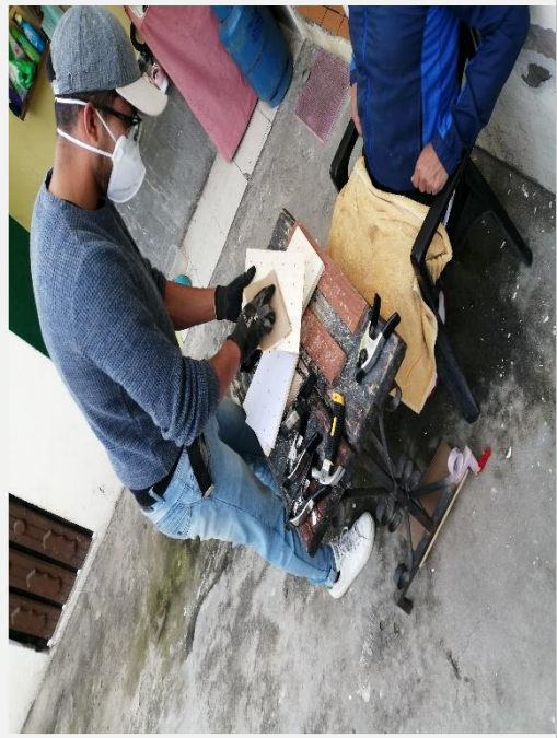
Fotografía 62. Lijando la superficie para tener mejor acabado
