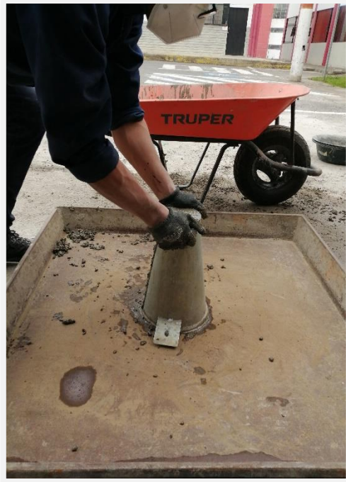
Fotografía 54. Retiro de cono
