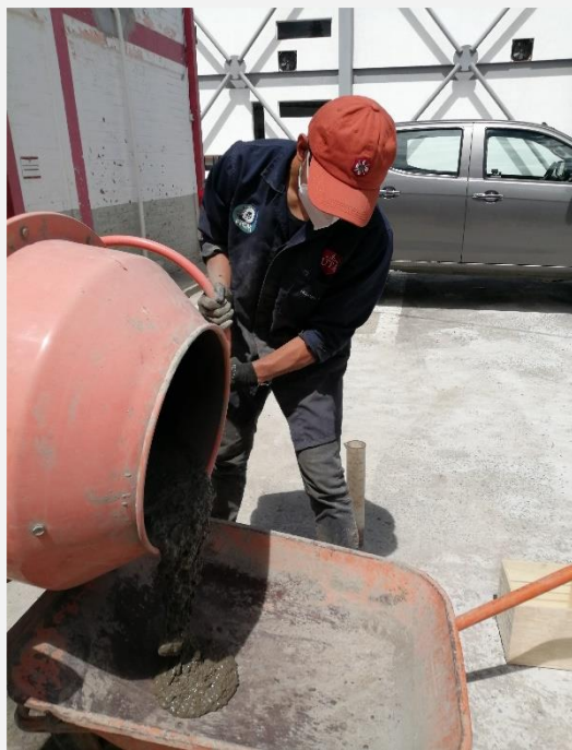
Fotografía 43. Colocación de la mezcla en carretilla para facilidad de trabajo
