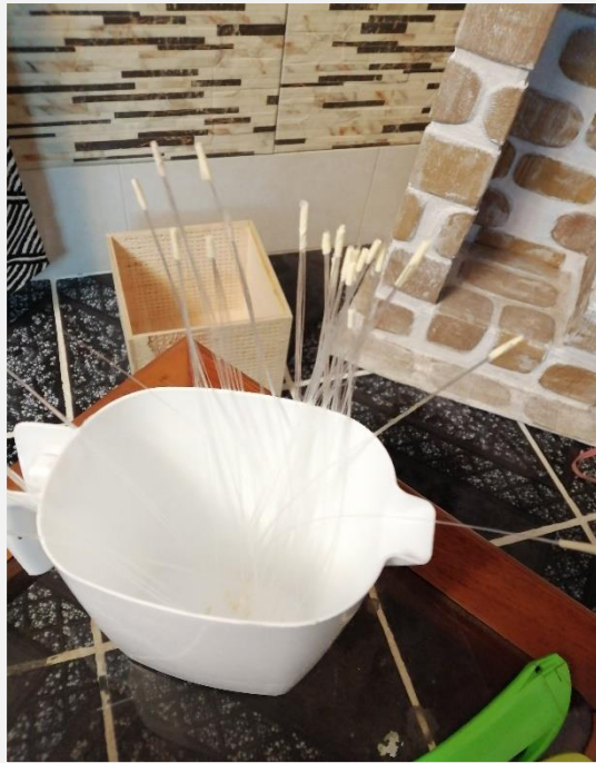
Fotografía 65. Armado de los paquetes de fibra óptica
