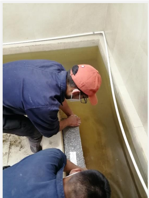
Fotografía 38. Colocación en la cámara de curado
