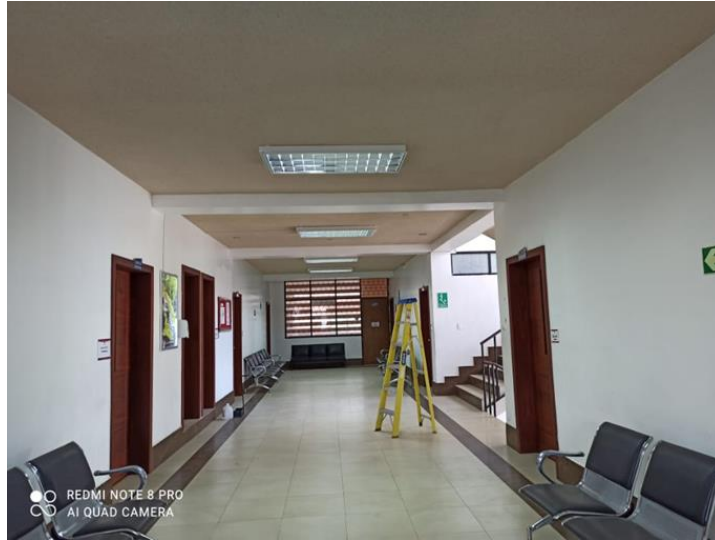
Figura 23: Acabados de la estructura.
