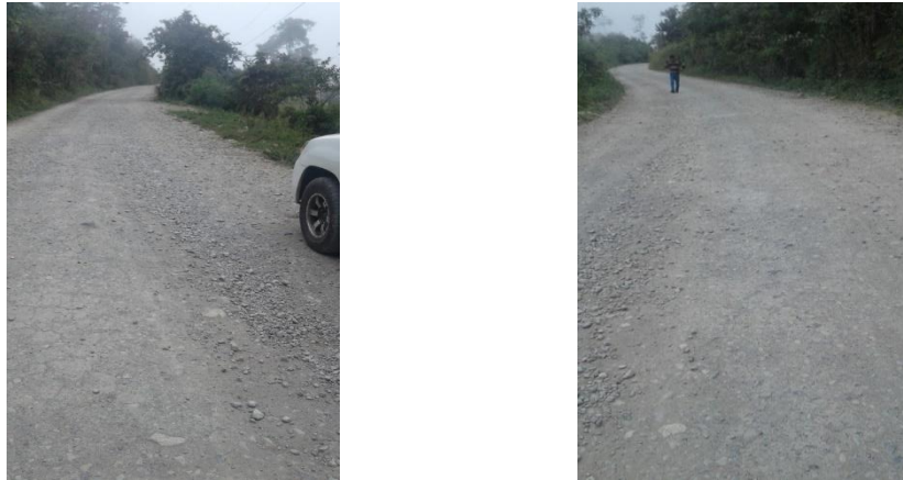
Estado Actual de la Vía.
