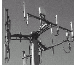
Gráfica 2.30. Antena cabeza de torre TDMA 1900 de tres sectores junto con antenas de diversidad de espacio.
