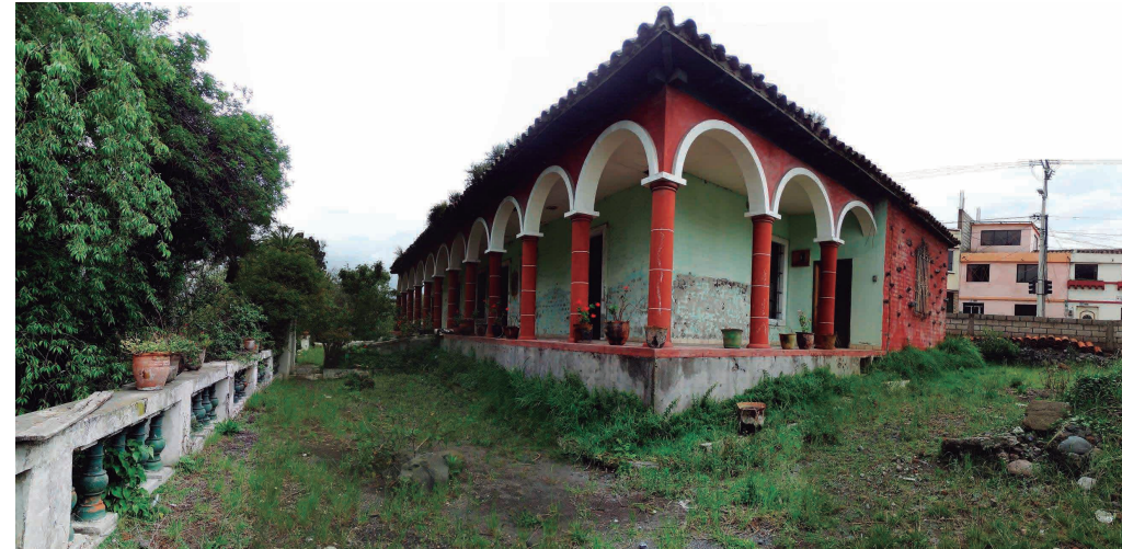
Fotografía 2: Fachada Norte y Oeste
