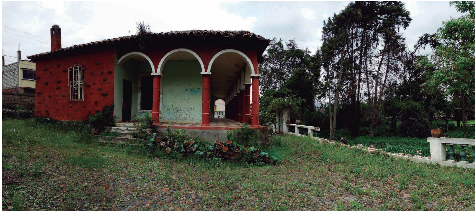
Fotografía 1: Fachada direccion Este y parte de patio de la casa
