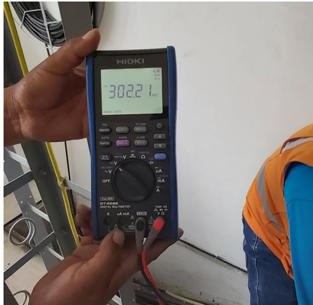
Figura 4.37: Medición de Voltaje en Tierra y Neutro
