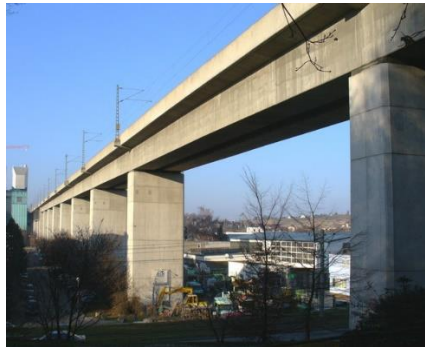
Figura 2.1: Puente de viga [1]
