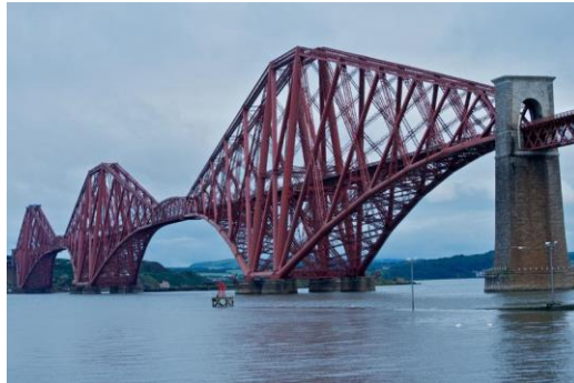
Figura 2. 2: Puente de ménsula
