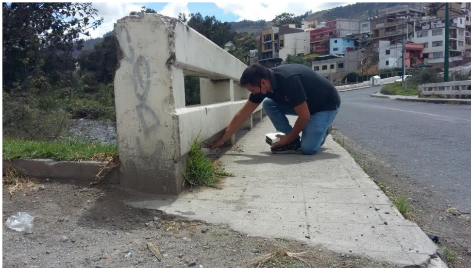
Figura 4.15: Ingreso este del puente “La Delicia”
