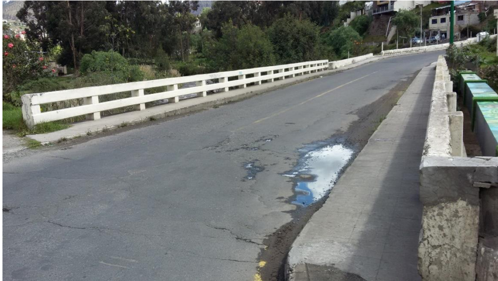
Figura 3.2: Puente “La Delicia” (Vista de Frente)
