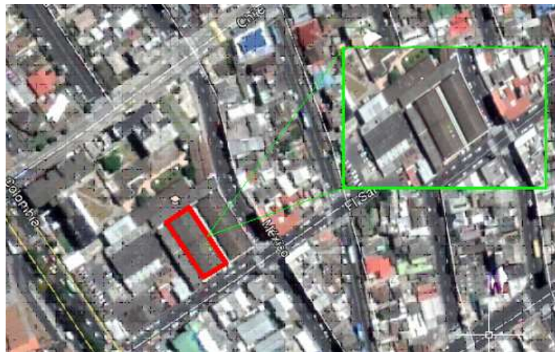
Figura 21: Ubicación de la estructura.
