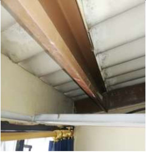
Disposición de correas en cubierta.
