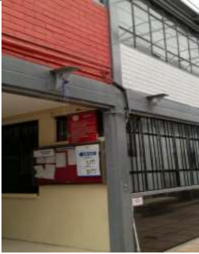
Disposición de vigas y columnas metálicas
