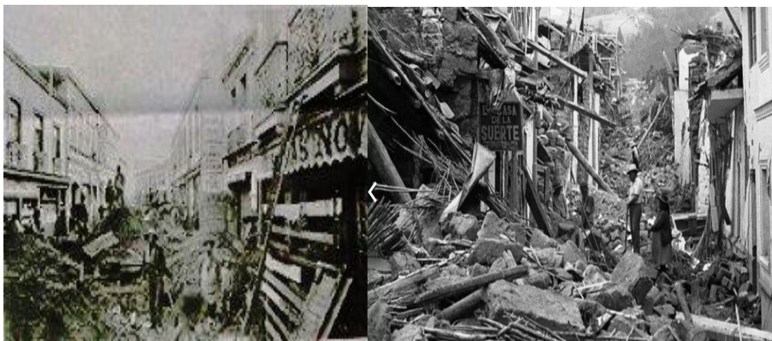
Figura 2: Daños en edificaciones sismo 31 de enero de 1906
