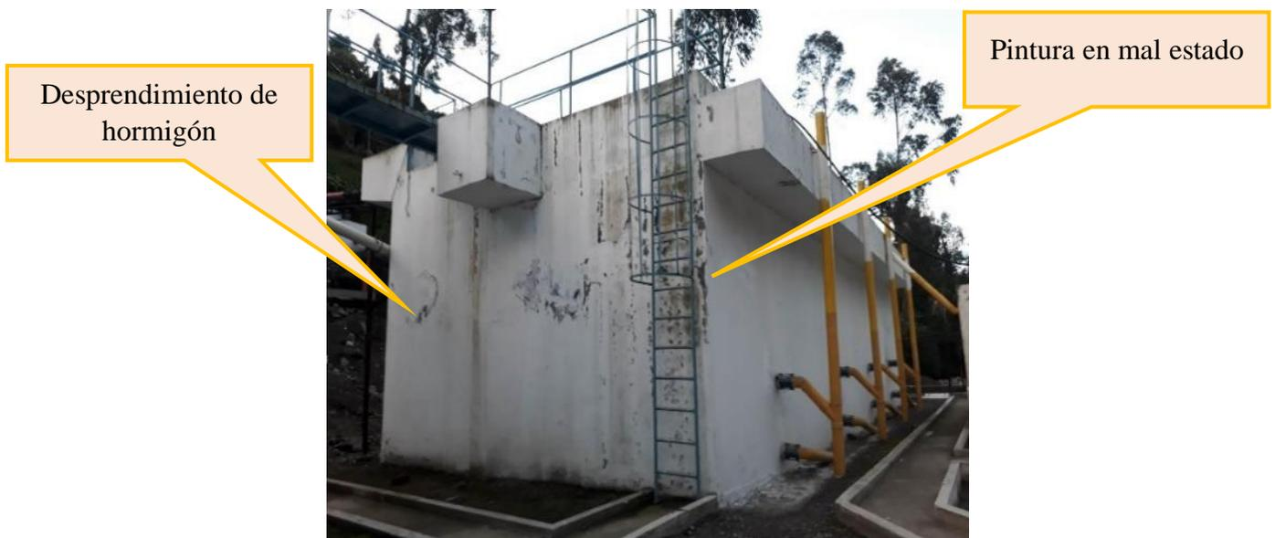
*Figura 46: Reactor anaerobio de flujo ascendente 2*
