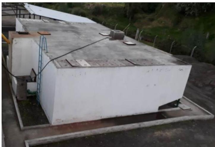
*Figura 48: Filtro anaerobio de flujo ascendente*
