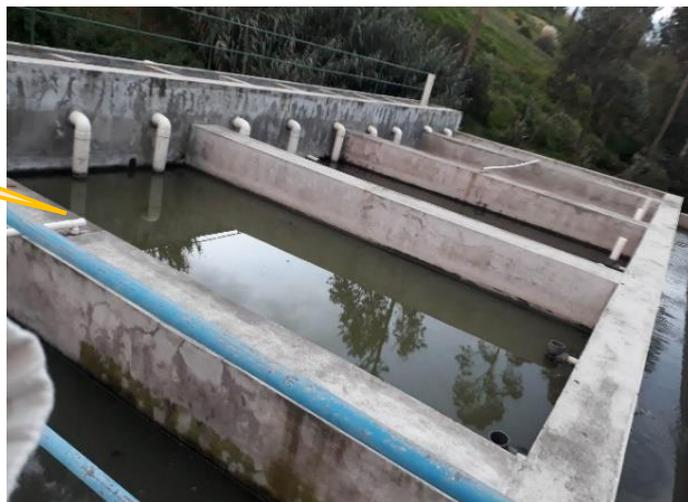
*Figura 47: Reactor anaerobio de flujo ascendente 1*
