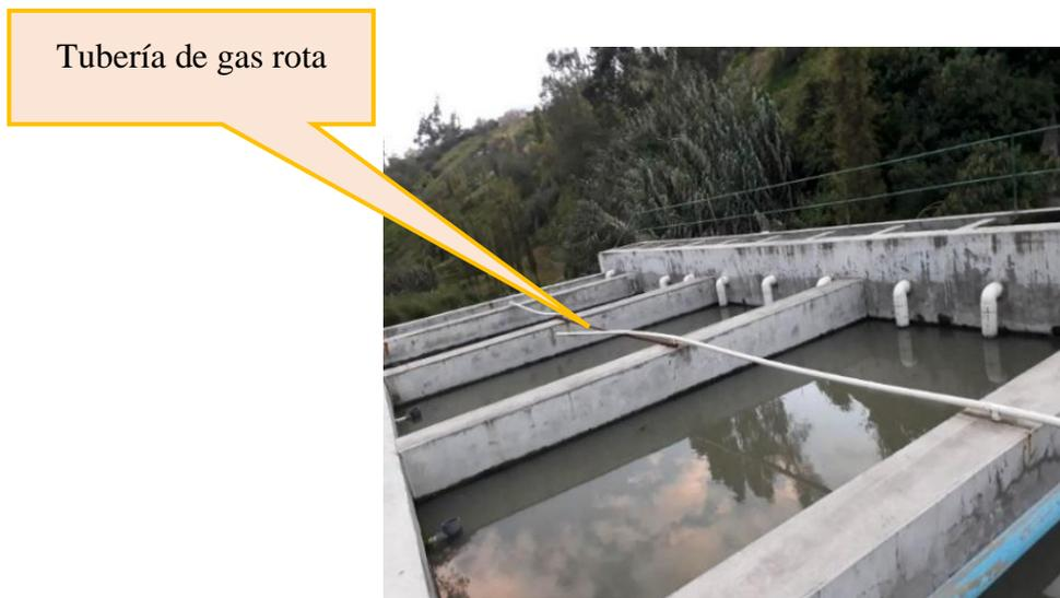
*Figura 45: Reactor anaerobio de flujo ascendente 1*
