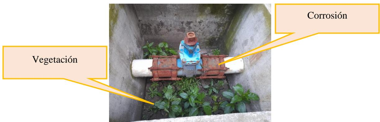
**Figura 52:** Válvula de control
