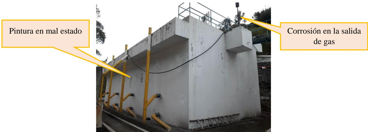
*Figura 44: Reactor anaerobio de flujo ascendente 1*
