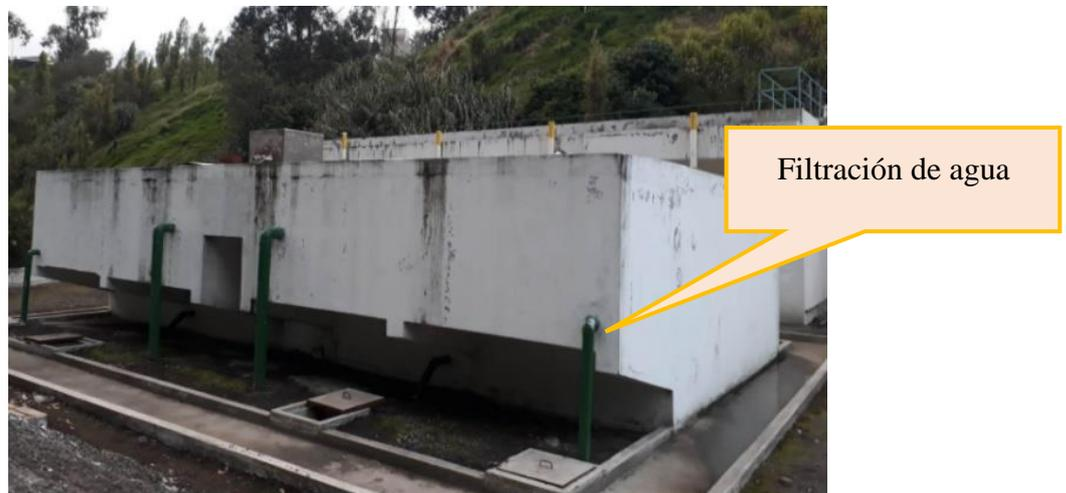
*Figura 50: Filtro Anaerobio de flujo ascendente 1*
