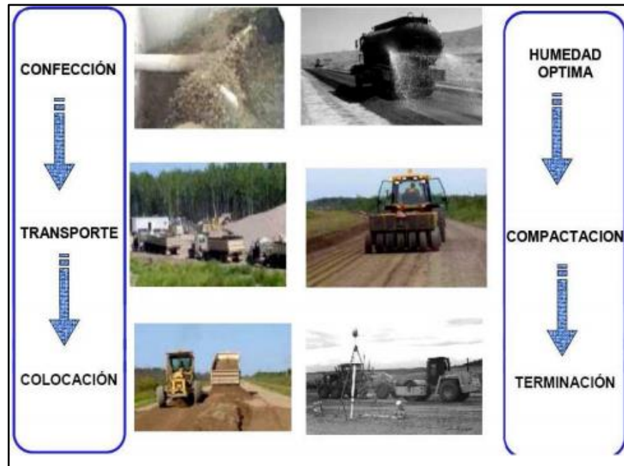
Figura 18.- Etapas para la preparación de la base.
