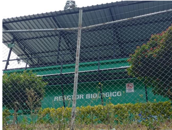
Imagen 44 Reactor Biológico– Planta de Tratamiento de Aguas Residuales La Rabija
