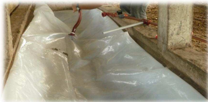
Tendido del PTD
