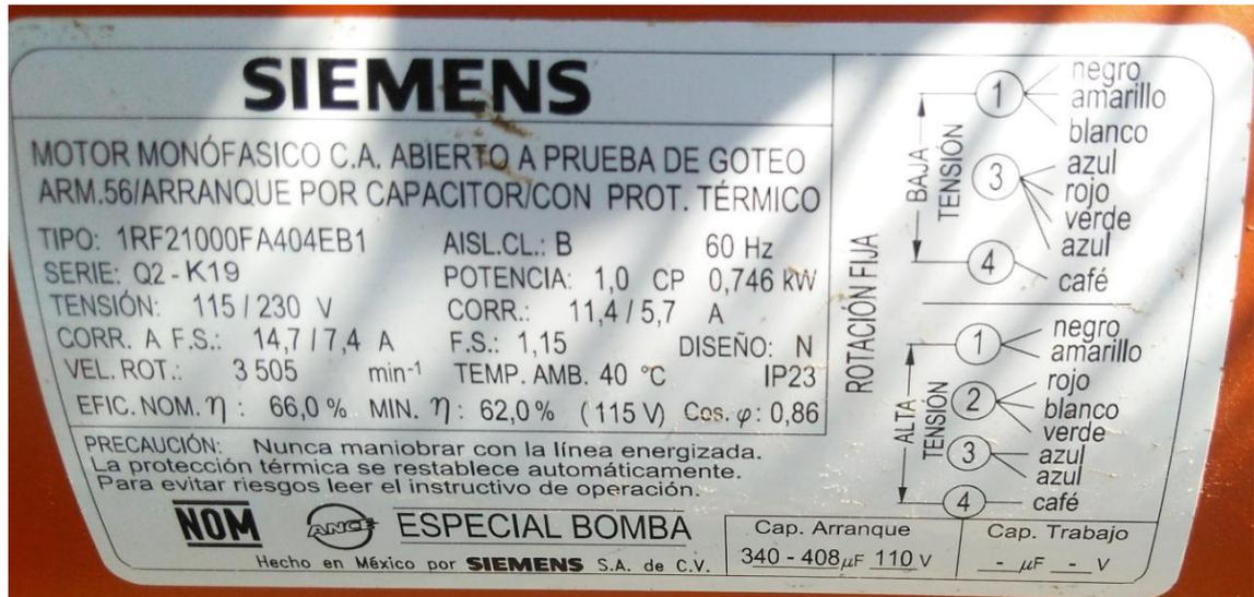
**Figura 1:** Placa bomba de agua monofásica Siemens 1 HP.
