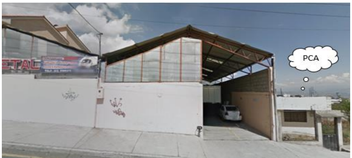
Figura 19. Croquis de la ubicación de la empresa Master Metal y la vivienda considera como crítica.
