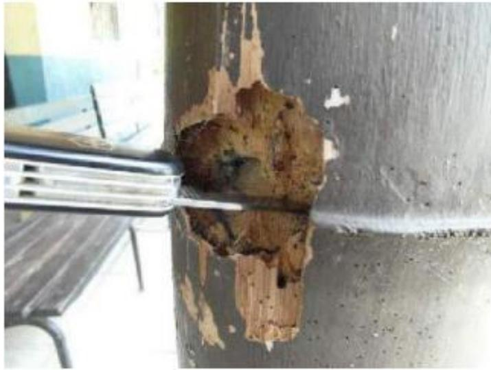
Figura 16: Daño severo debido a las termitas [25].
