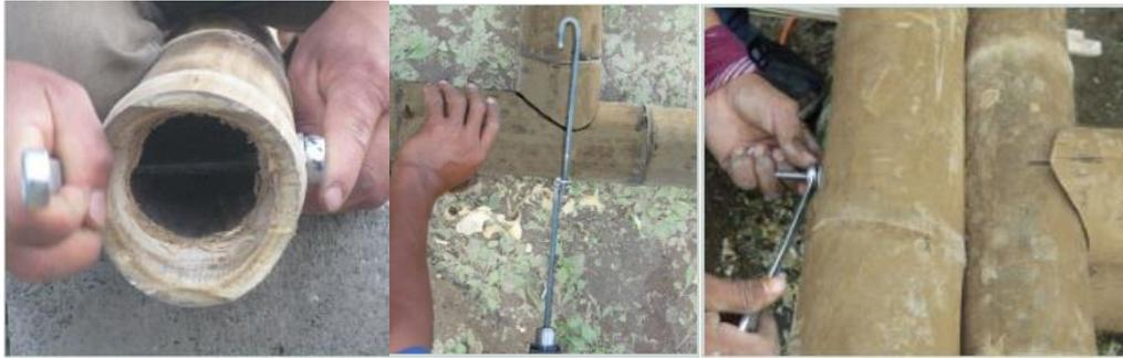
Figura 26: Pasos para realizar una unión con perno tensor [12].
