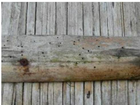
Figura 15: Daño en el bambú provocado por escarabajos [25].
