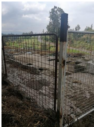
Figura 46. Cerramiento de la PTAR cantón Cevallos
