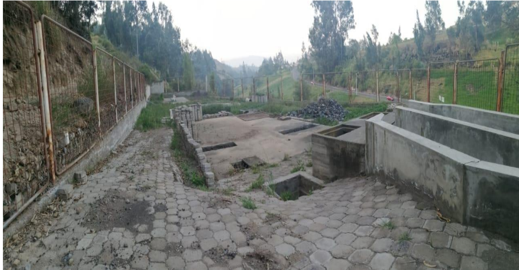
Figura 50. Estado actual de la PTAR del cantón Cevallos
