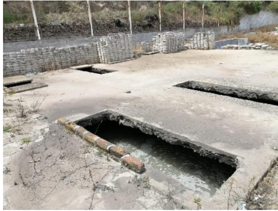
Figura 39. Sedimentador Primario PTAR cantón Cevallos
