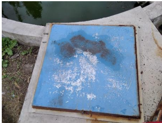
Figura 44. Compuertas de protección PTAR cantón Cevallos
