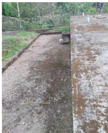
*Figura 8. Lecho de secado de lodos*
