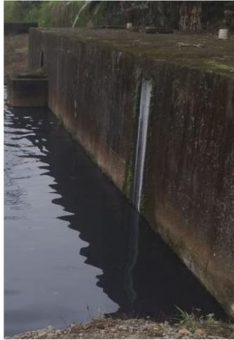
*Figura 14 Filtración en el tanque séptico*
