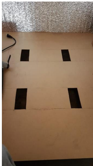
Figura 4-12 Instalación de macetas
