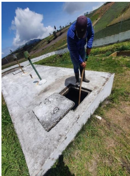
Figura 11. Toma de caudal de ingreso a la PTAR de la comunidad Hualcanga San Luis.
