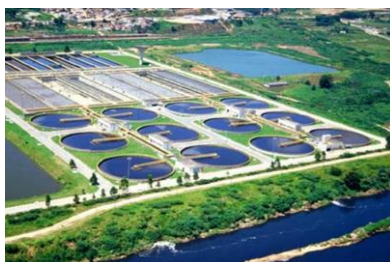
Figura 5. Planta de tratamiento de aguas residuales.
