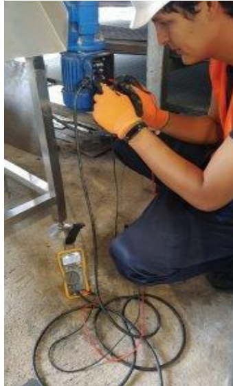
Figura 24 Mantenimiento del motor de los rodillos
