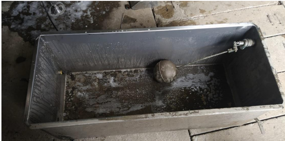
Figura 22 Limpieza del tanque de agua
