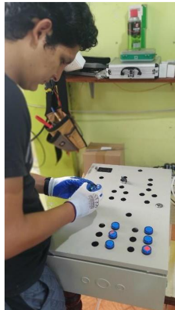
Figura 50 Colocación de botones de control y luces indicadoras
