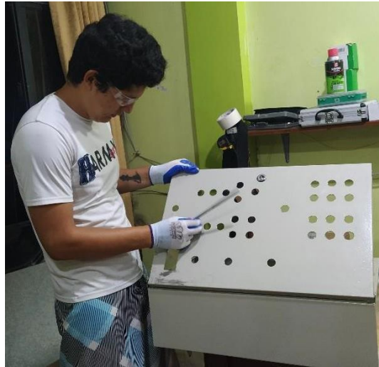
Figura 49 Perforación de agujeros en el tablero de control
