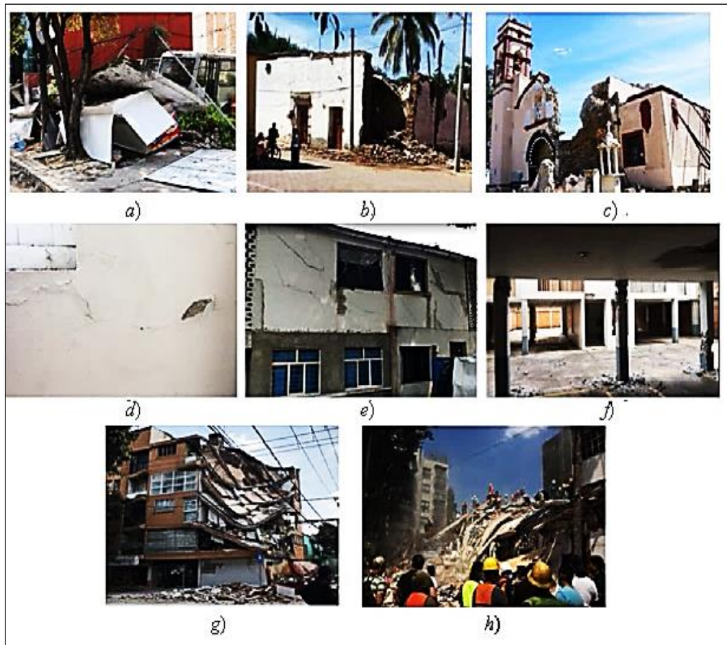
Figura 10: a) daño en bardas, b) estructuras débiles y sin ingeniería, c) estructuras antiguas, d) grietas en acabados y elementos no estructurales, e) grietas pequeñas en muros, traveses o columnas, f) grietas importantes en muros, traveses o columnas, g) colapso de pisos superiores y h) colapso [10].
