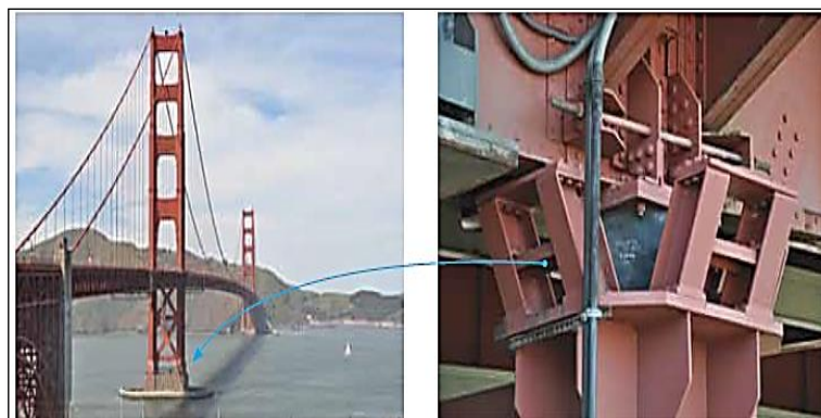
Figura 26: Puente Golden Gate – San Francisco (EEUU) - Aisladores elastoméricos.
