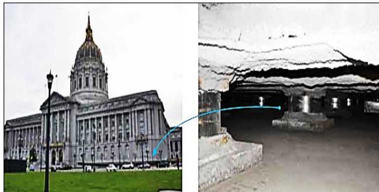
Figura 25: San francisco City hall – EEUU- Aisladores elastoméricos
