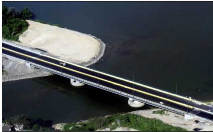
Figura 22: Puente “Norte” (consta de 4 puentes) – Esmeraldas -Ecuador, aisladores FPS construido en 2010
