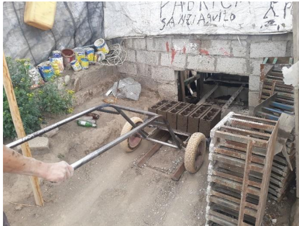
Desmolde de bloques.
