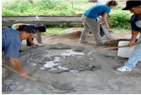
Figura 7. Mezcla manual de agregados.
