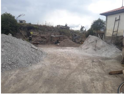
Almacenamiento de ripio y polvo gris.
