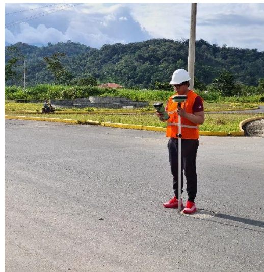
Fotografía 12. Punto de descarga hacia el alcantarillado existente
