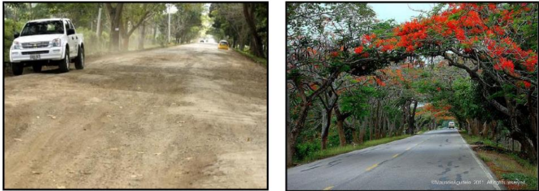
Figura 11. Proyección de vía terminada
