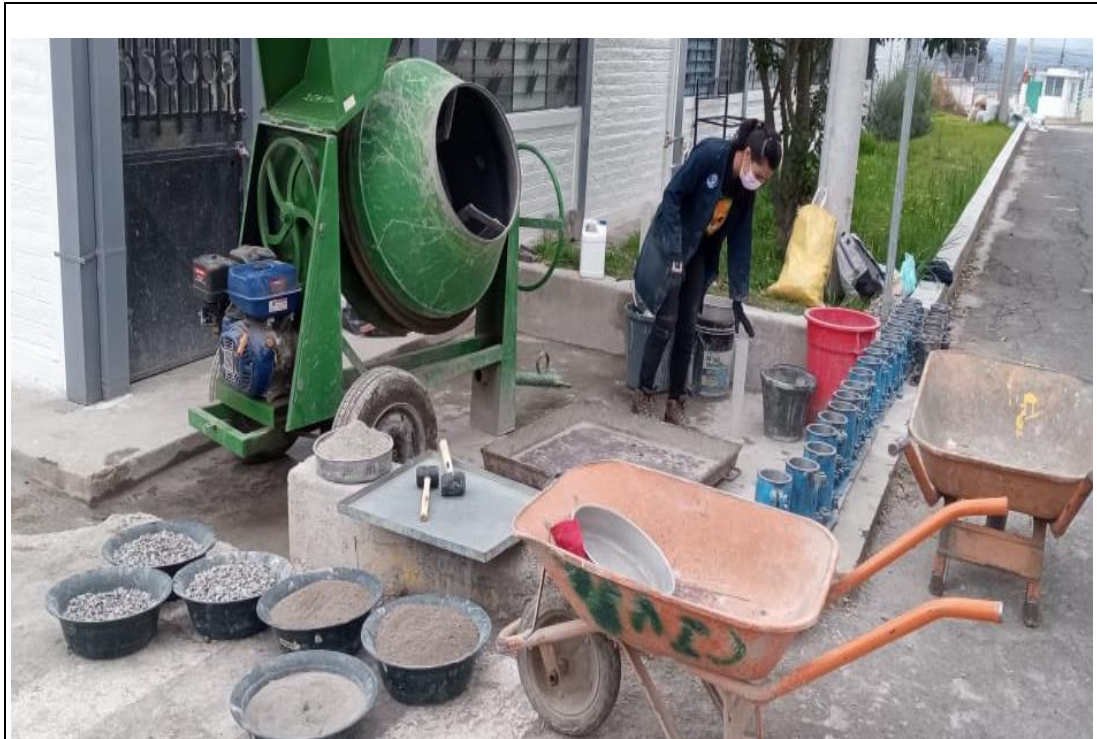
Fotografía 29.- Preparación de cada uno de los materiales y equipos para la elaboración del hormigón.
