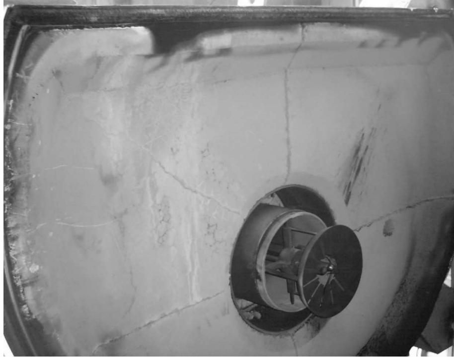
Foto 15: Compuerta delantera limpia, se puede apreciar que el refractario se encuentra en perfecto estado, no requiere reparación ni tampoco ser reemplazado.
