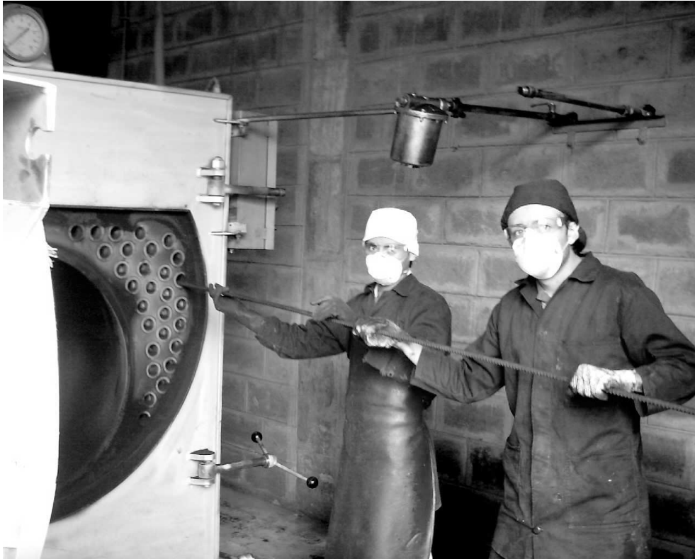
Foto 11: Proceso de vaqueteado en cada uno de los 58 tubos que conforman el caldero.
