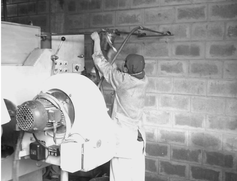
Foto 19: Una vez cerradas la compuerta delantera y las compuertas posteriores, se realiza la reconexión de las tuberías de ingreso de ingreso y retorno de combustible.
