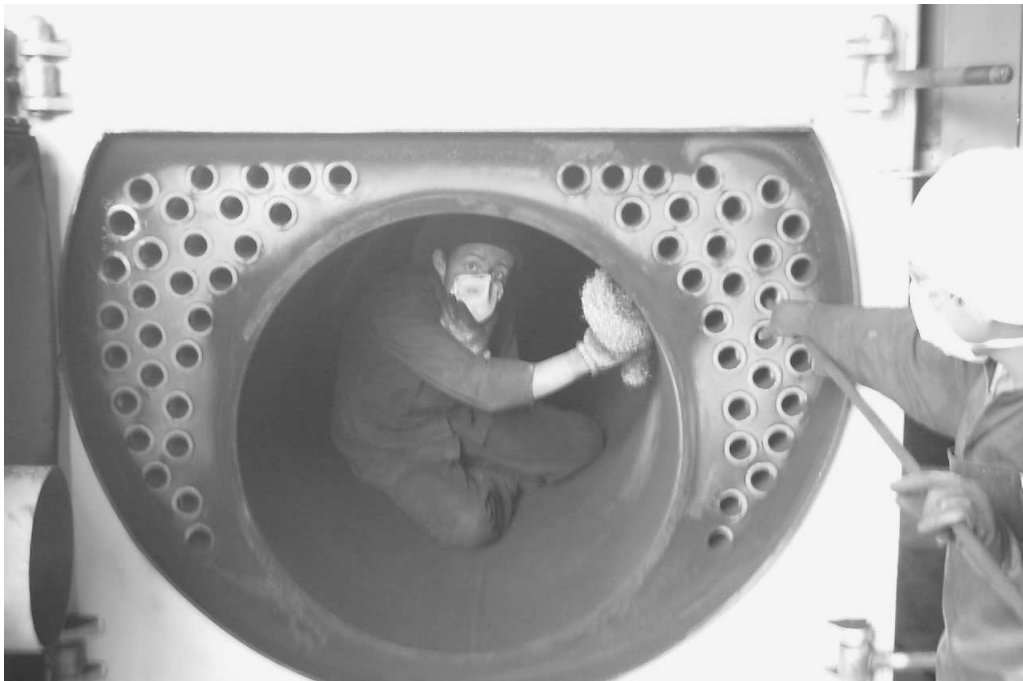
Foto 12: Limpieza del hogar del caldero
