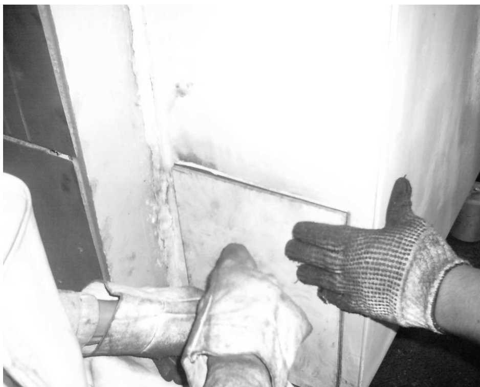
Foto 18: Una vez recogido el hollín de la cámara posterior, se procede al cierre de las compuertas posteriores.
