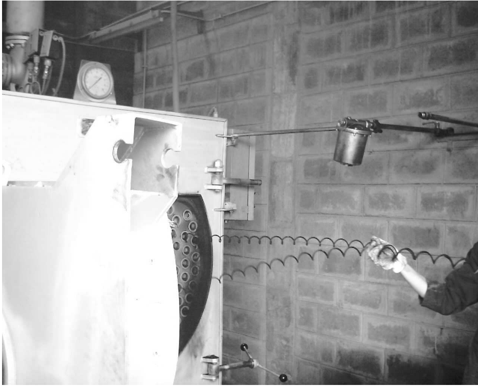
Foto 09: Extracción del sistema varillaje de cada uno de los 29 tubos de cada lado, es decir 58 varillas en total.
