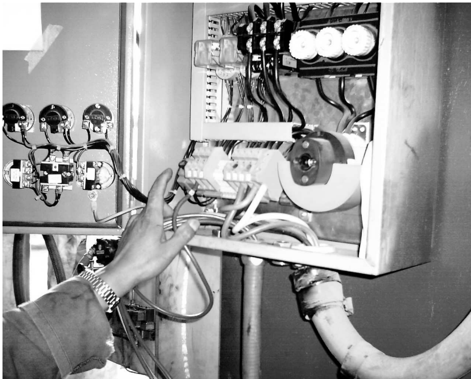
Foto 20: Reconexión eléctrica del tablero de control.
