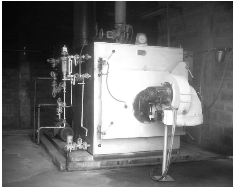
Foto 24: Posteriormente se acciona un pistón en el Damper, el cual levanta y acciona la compuerta del Damper y actúa como un micro, que enciende el ventilador, mediante un émbolo, si sale humo negro existe demasiado combustible y si sale humo blanco existe demasiado aire.
