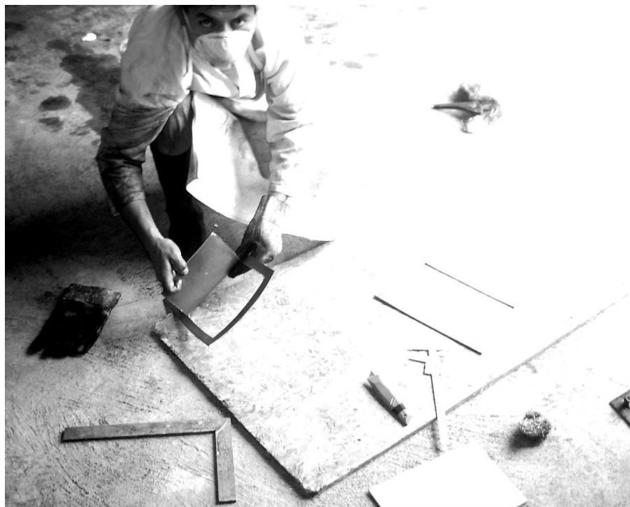
Foto 17: Colocación de asbesto grafitado en las compuertas posteriores del caldero
