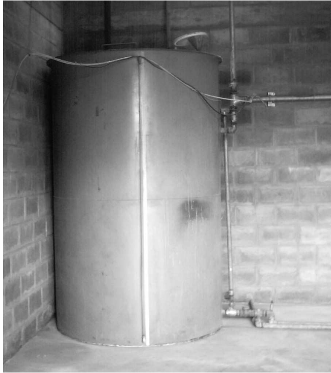
Foto 21: Reapertura de la válvula de alimentación de agua.
