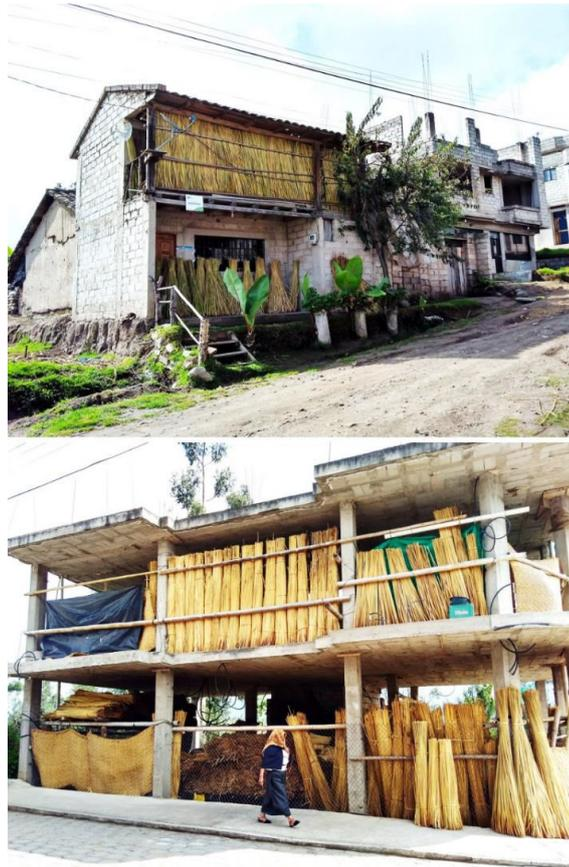
**Imagen 9:** Construcciones mixtas hormigón y totora en Huaycopungo
